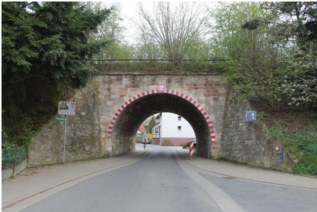
Viadukt Atzbach von Kinzenbach her kommend
