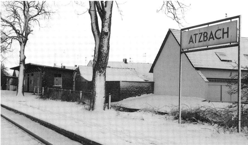
Der Haltepunkt Atzbach an der Kanonenbahn 1978. Noch findet fahrplanmäßige Personenbeförderung in Triebwagen zwischen Wetzlar und Lollar statt. Aber nicht mehr lange.
