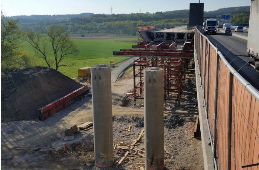
Für Abbruch und Neubau der Dorlarer Lahnbrücke ist der Bahndamm der ehemaligen Kanonenbahn (links ist der angeschnittene Damm zu sehen) auf etwa 70 Metern Länge abgetragen worden. Das Material wird bis zum Ende der Bauarbeiten in der Nähe gelagert, um dann wieder neu aufgeschüttet zu werden. Ob sich in dem Erdreich Schafstoffe befinden, ist laut Oberer Naturschutzbehörde nicht untersucht worden. (Archivfoto: Reeber)
