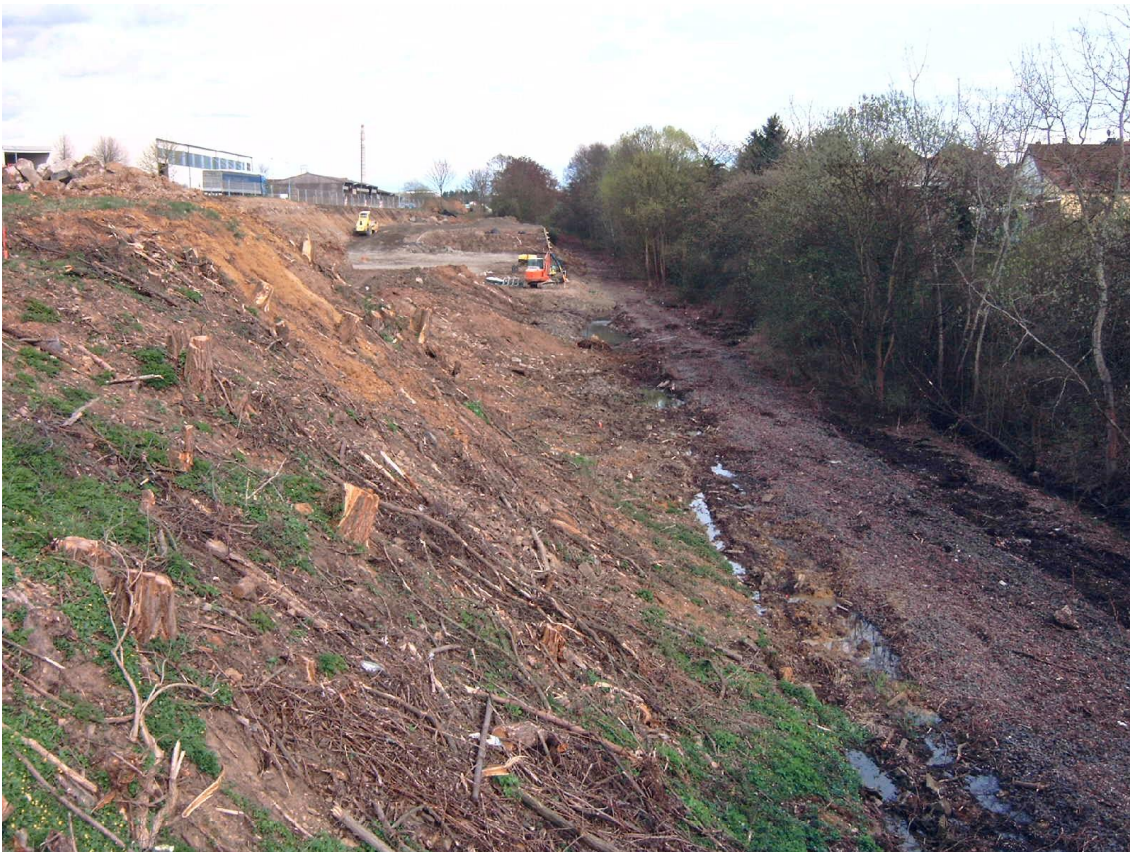
Aufarbeitung der alten Deponie Dorlar 2006 Foto: R. Stahl
