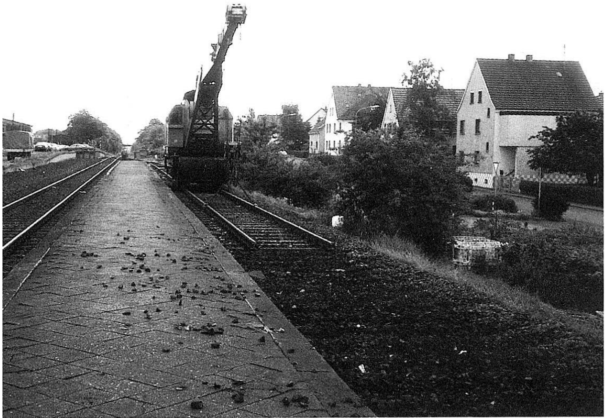
Entfernung der Gleisanlage im Bereich des Bahnhofes Dorlar im Jahr 1985. Der gesamte Schienenstrang von Wetzlar nach Lollar wurde erst 15 Jahre später gänzlich entfernt.
