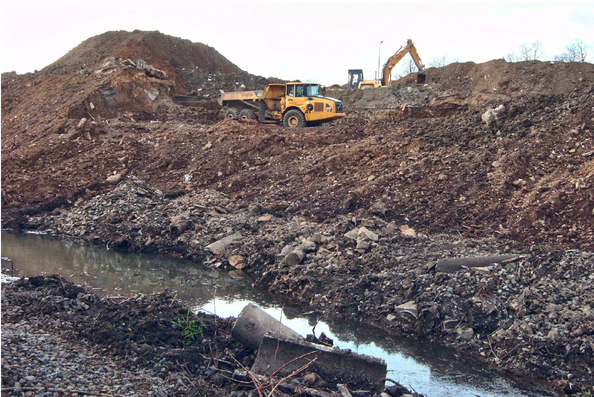
Aufarbeitung der alten Deponie Dorlar 2006
