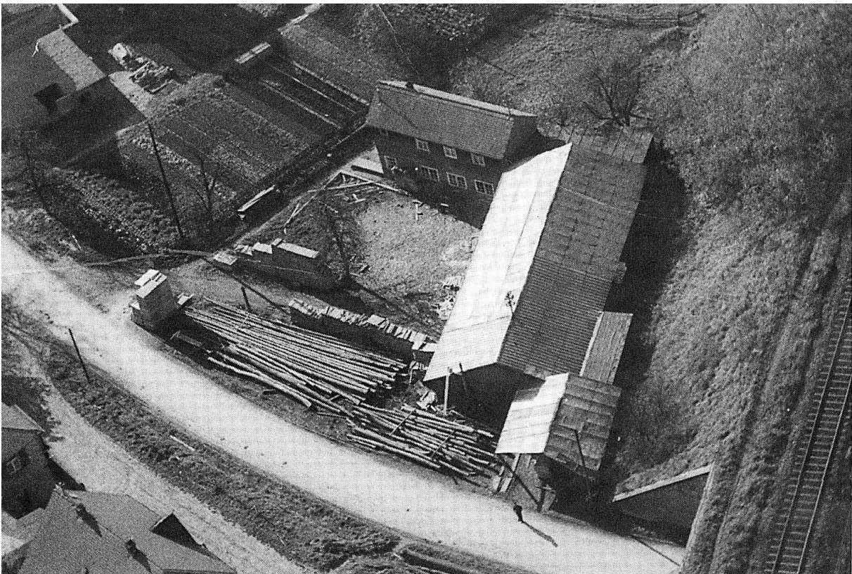
1955 (um) Der Zimmerplatz von Heinrich Weller und dessen Sohn Paul am Waldweg 27 (heute Kinzenbacher Straße) in Atzbach. Im Bildvordergrund, rechts, die Gleise der „Kanonenbahn“, die dort über den Waldweg führen. Das Zimmergeschäft wurde von 1931 bis 1994 betrieben.
